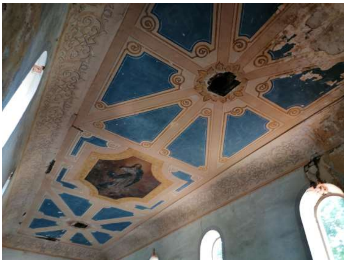
Zdj.9 Sufit nawy głównej z obrazem do zabezpieczenia
